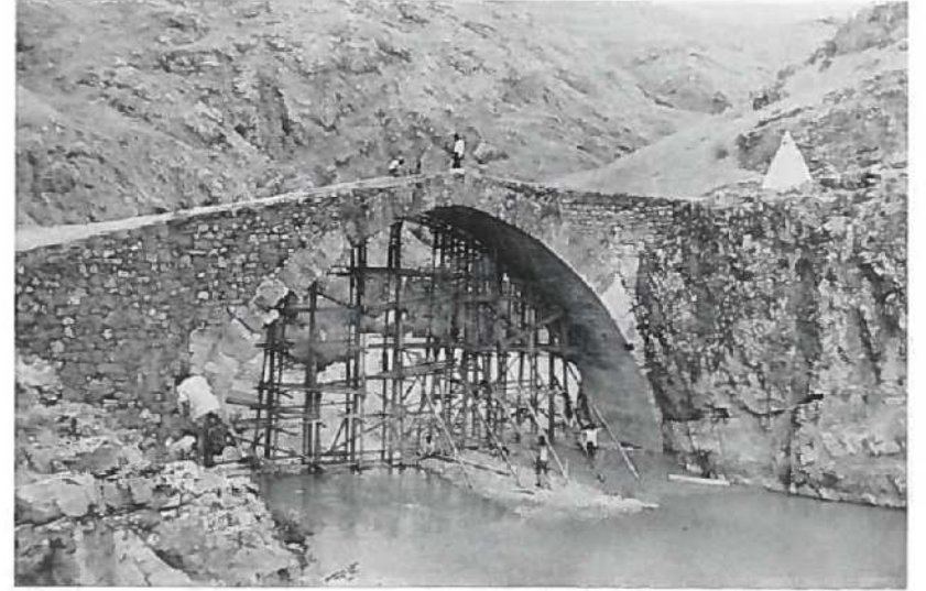
2 Köprünün mansap tarafı görünüşü View of the upstream side of the bridge
